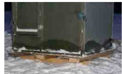
Det är klokt att ställa kojan på en lastpall eller annat stadigt underlag. Barmarkstid för att skydda den från markfukt, vintertid för att slippa snöknarr under golvet.
