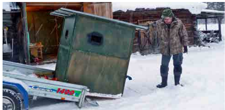
Lyftögglor - exempelvis av ett kasserat spännband - i varje knut underlättar hanteringen av kojan när den ska flyttas.
